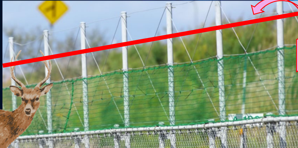
मृग वा अन्य पशु आक्रमण निवारण नेटमा जोडिएको छ, यसले जनावरहरूलाई मैन नपर्ने एक आवृत्तिमा प्रकाश उत्सर्जन गर्दछ। यसबाहेक, जनावरलाई अप्रिय गन्ध रेजिनमा मिसाउने काम प्रभावकारि मानिन्छ ।
