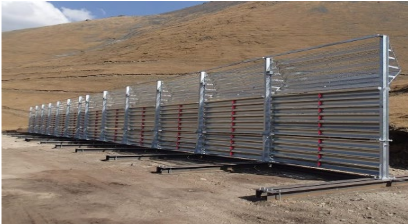
Гадаад улсад дэмжлэг үзүүлэх төслөөр Бүгд Найрамдах Киргиз улсад цаснаас хашаа суурилуулсан байдал
